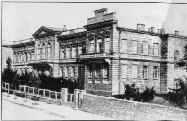
Le bâtiment de l'école normale dans la rue d'Astafyev dans la ville d'Iravan (XIX siècle)
